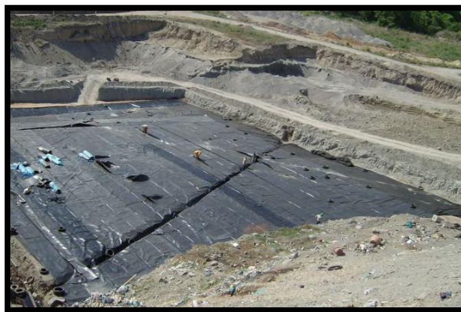
Ilustración 26 Colocación y Extendida del Lecho Filtrante
